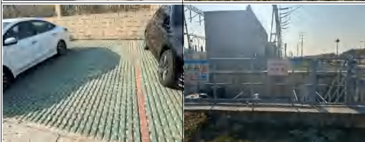
厂区降水蓄渗工程
