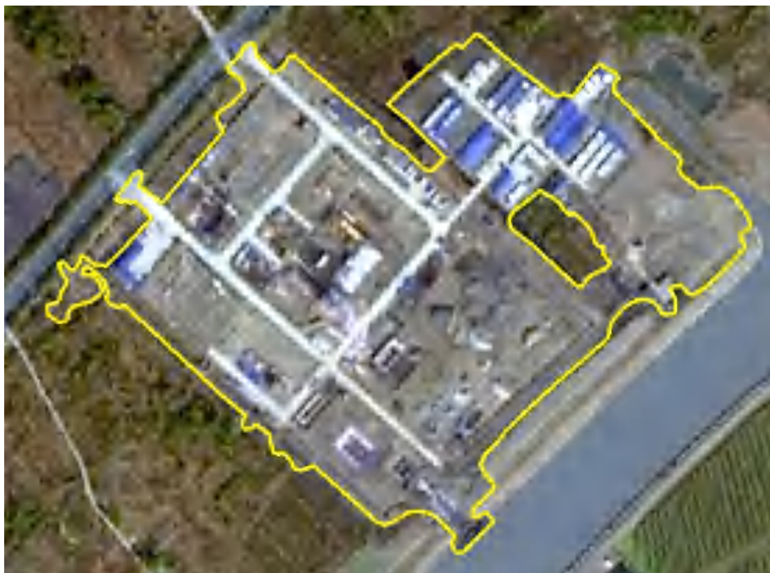
2021 年项目区影像（基础施工期）
