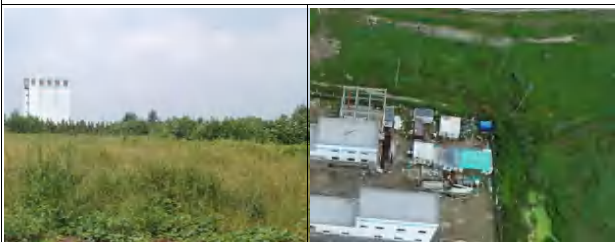
取水设施区植被建设工程
