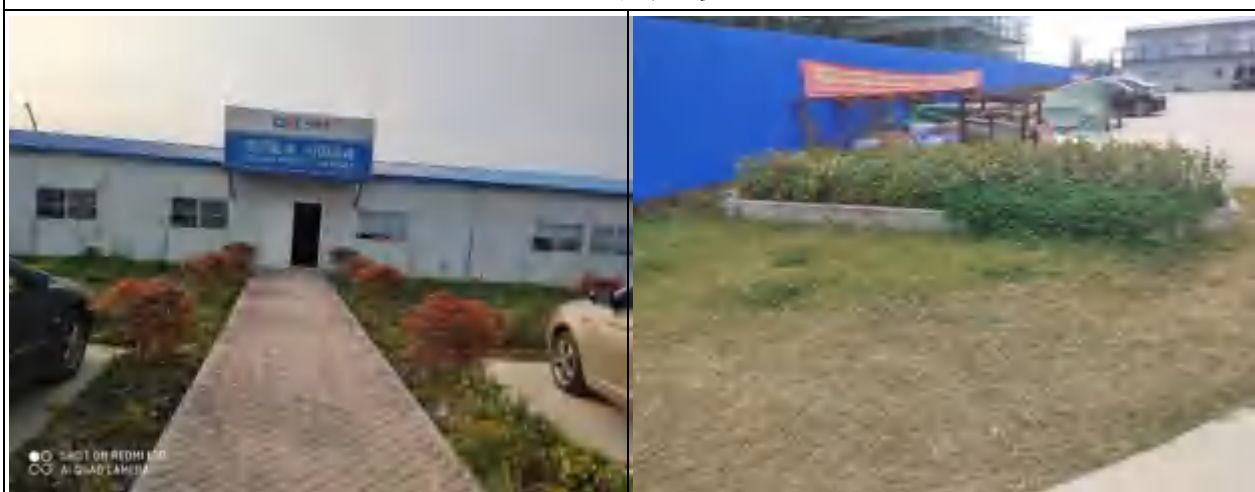
施工生产生活区植被建设工程
