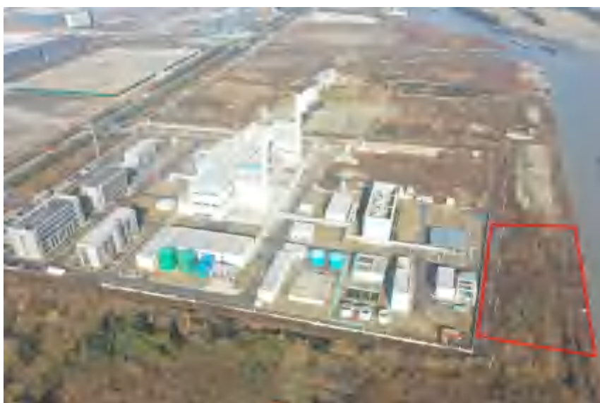
取水设施区临时占地恢复情况
