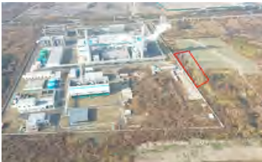
施工生产生活区临时占地恢复情况
