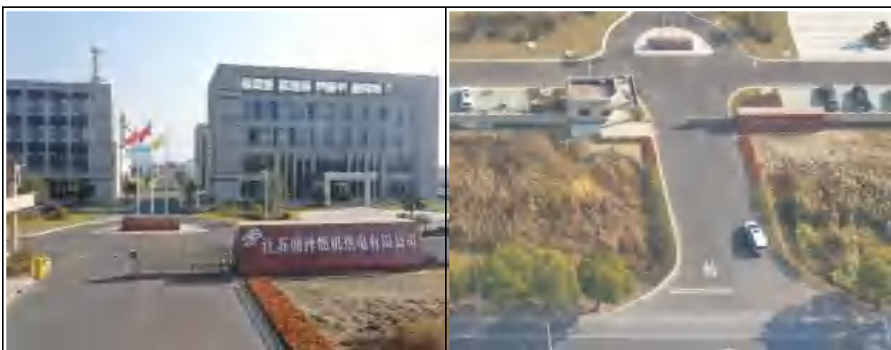
进场道路区植被建设工程
