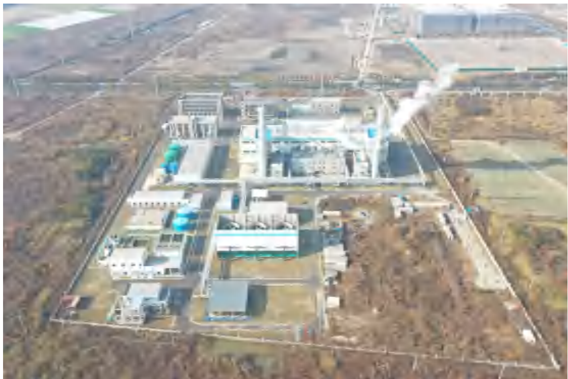
2024 年项目区影像（完工后）
