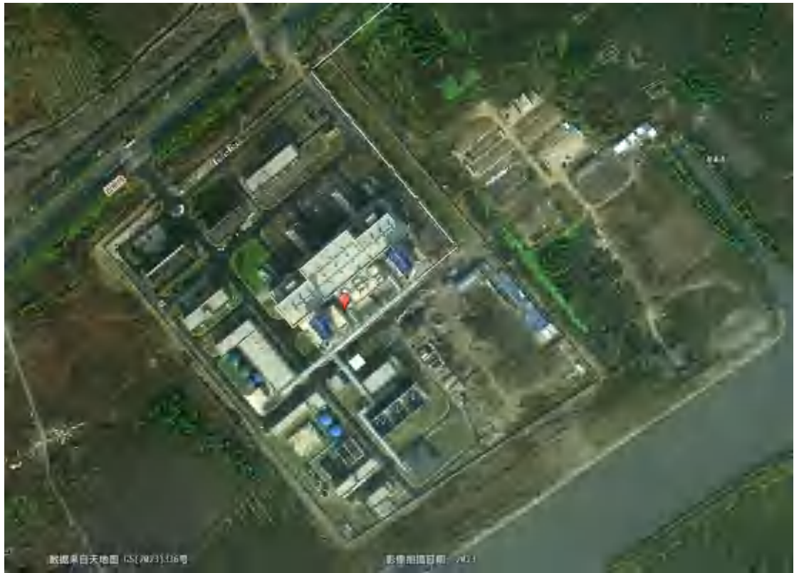
2023 年项目区影像（施工末期）
