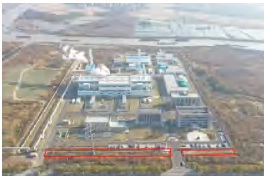
厂区临时占地恢复情况
