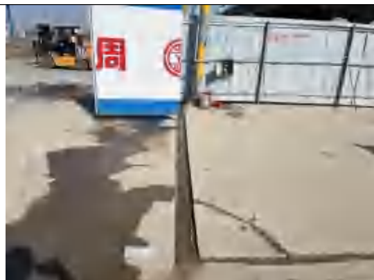
措施内容：临时排水沟
