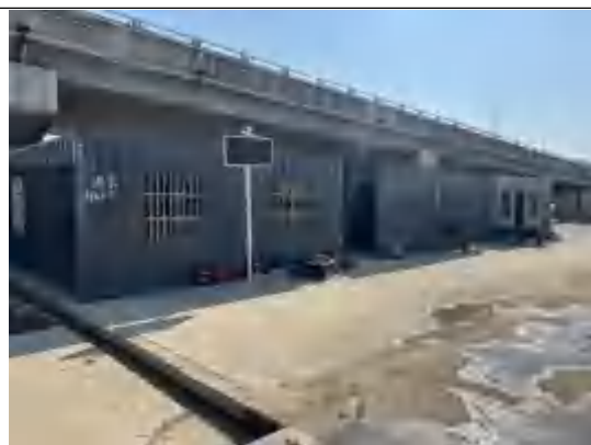
措施内容：临时排水沟
