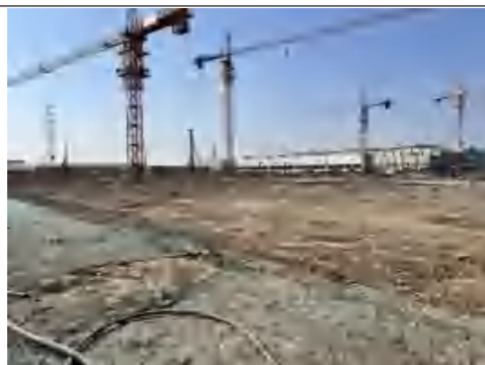
措施内容：临时苫盖
