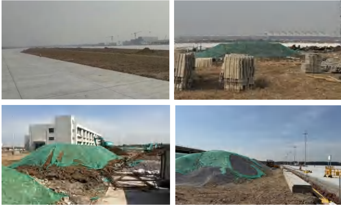
图 3.3-1 施工期间临时堆土情况
