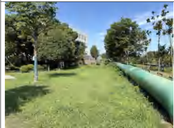
管线临时占地绿化（2026 年 7 月）
