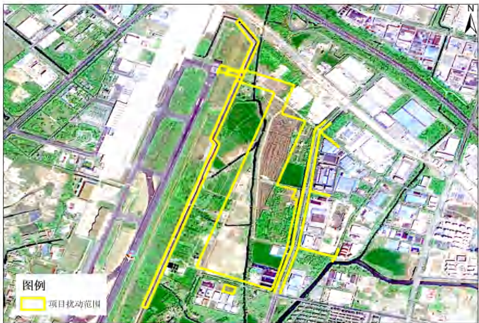
2023 年（项目施工中）
