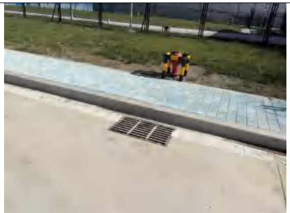
配套设施区雨水管线（2026 年 7 月）
