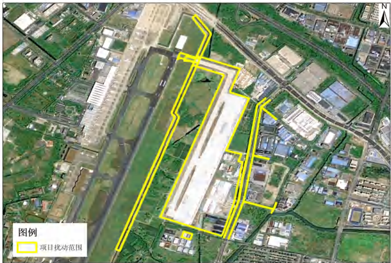
2025 年（项目施工中）
