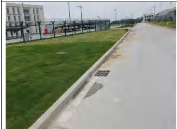
配套设施区雨水管线（2026 年 7 月）
