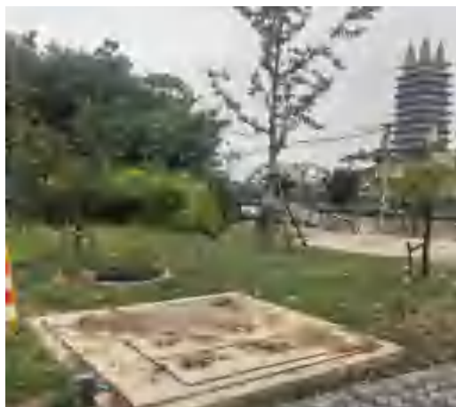
管线工程区撒播草籽（2026年6月）
