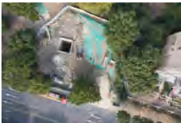
管线工程区临时苫盖（2025年12月）
