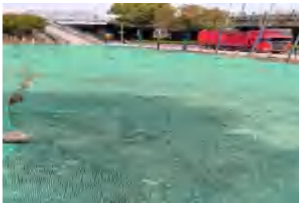
管线工程区临时苫盖（2026年3月）
