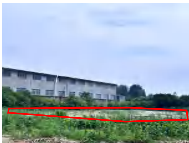
图3.4.2-4 金联村顾家塘地块坑塘回填项目场地现场照片（2026年6月30日）
