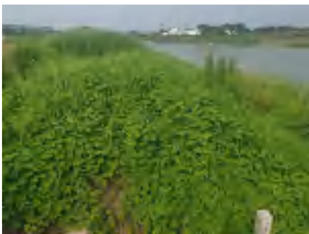
图3.4.2-9 金坛区湟里河综合整治工程场地现场照片（2026年6月30日）
