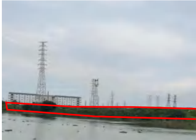
图3.4.2-11 武进区遥观镇东方村坑塘回填项目场地现场照片（2026年6月30日）
