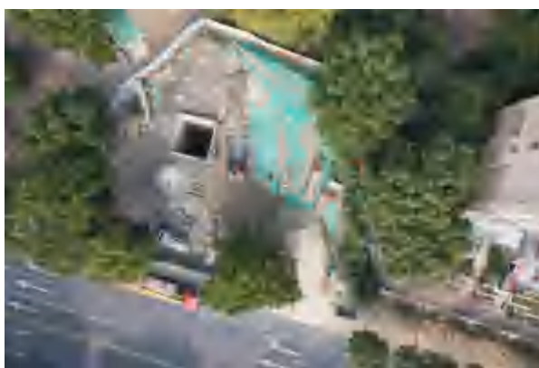
管线工程区临时苫盖（2025年12月）
