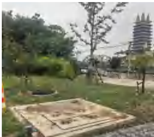
管线工程区撒播草籽（2026年6月）
