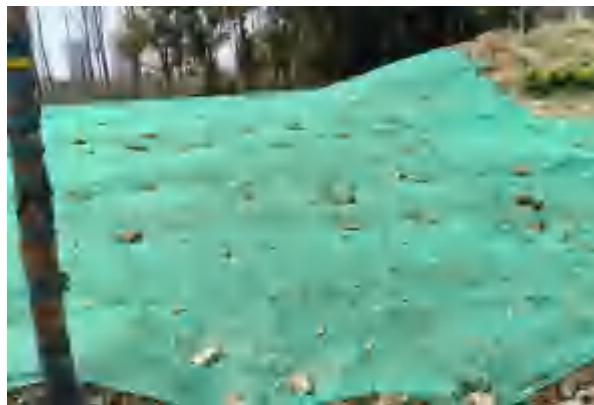
管线工程区临时苫盖（2026年3月）
