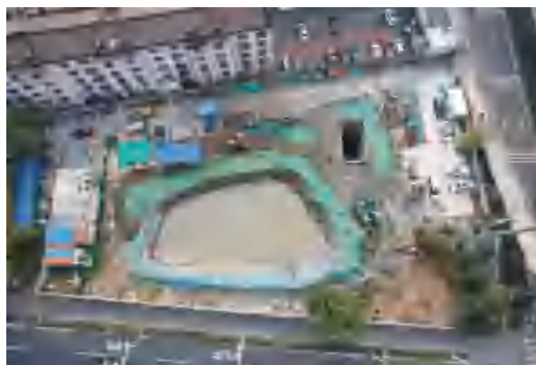
管线工程区临时苫盖（2025年12月）
