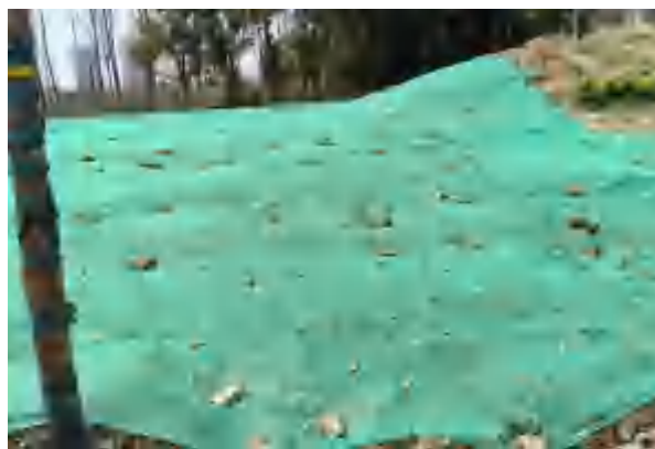
管线工程区临时苫盖（2026年3月）
